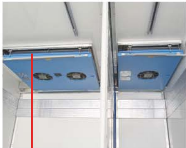
2-Zonenanlage mit Unterflur- maschine
